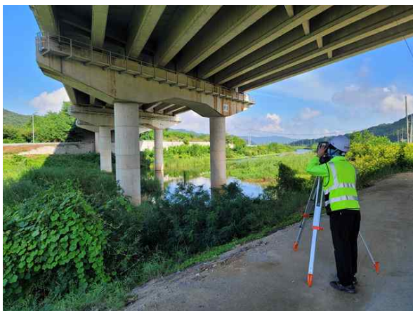
광파기를 이용한 측량 작업
